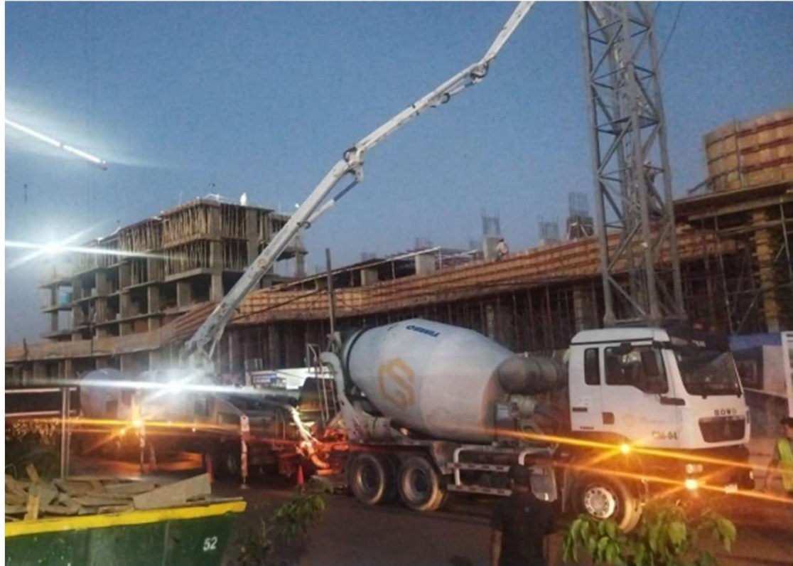
Cargamento de Losa N1 – Sector B
