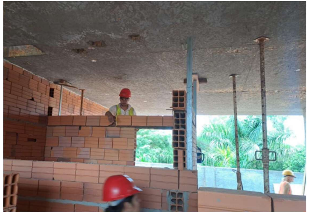
Mampostería de elevación en nivel N1 de la TH1
